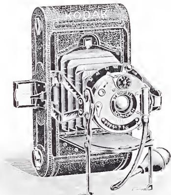
Zentral-Verschluß (Koilos oder Compound) mit einem Orthostigmat eingesetzt und durch eine Hebelvorrichtung mit Skala die bequeme Einstellung auf nahe Distanzen bis zu zwei Meter ermöglicht. Der Apparat ist auf diese Weise für alle Zwecke, insbesondere für kurze Belichtung und Nahaufnahmen brauchbar ge-
